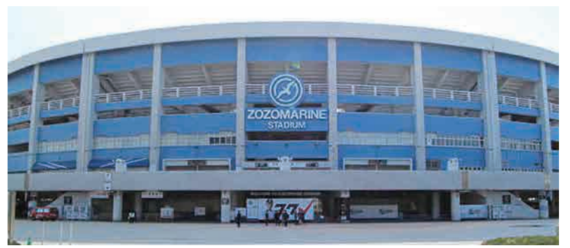
▲ZOZOマリンスタジアム空調設備改修工事
