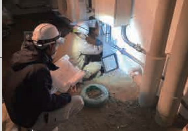
▲行先表示札取付作業
