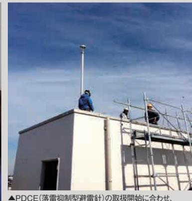
▲PDCE(落雷抑制型避雷針)の取扱開始に合わせ、避雷設備工事にも進出
