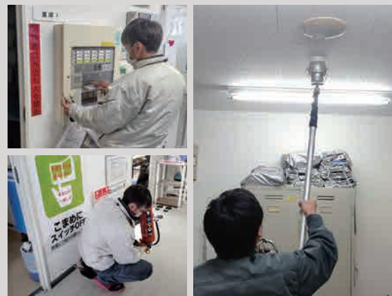
▲保守点検作業の様子
